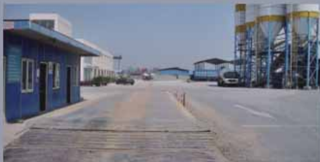
永源混凝土 3.5-16.5m 120t
